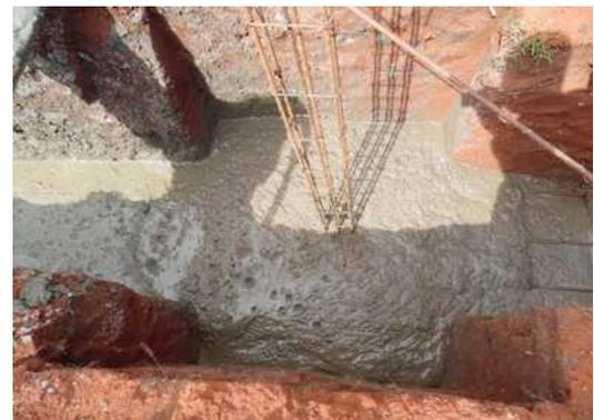
Die Eiseneinlage der Pfeiler wird in das Fundament
