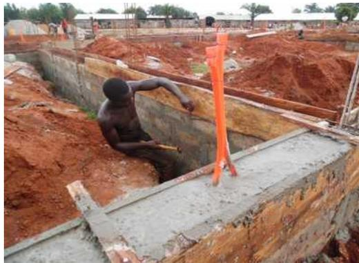
Der Eisenanker, in den die Stromversorgung eingearbeitet ist, wird gegossen.
