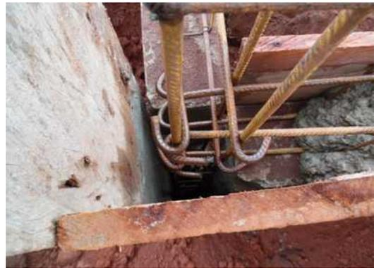
Die Mauern werden auf der bewehrten Fundamentunterlage errichtet und die Verschalungen für den unteren Eisenanker angebracht.
