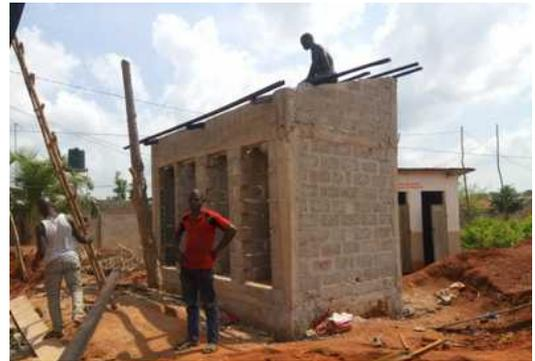
Das Holz für die Dachstühle ist auf der Baustelle eingetroffen und wird gegen Termitenbefall behandelt. Danach werden die Dachstühle für die Gebäude und die Toiletten gezimmert.
