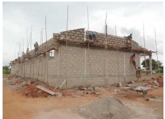
Inzwischen wird an den Gebäuden der obere Eisenanker gegossen und die Giebel aufgemauert.
