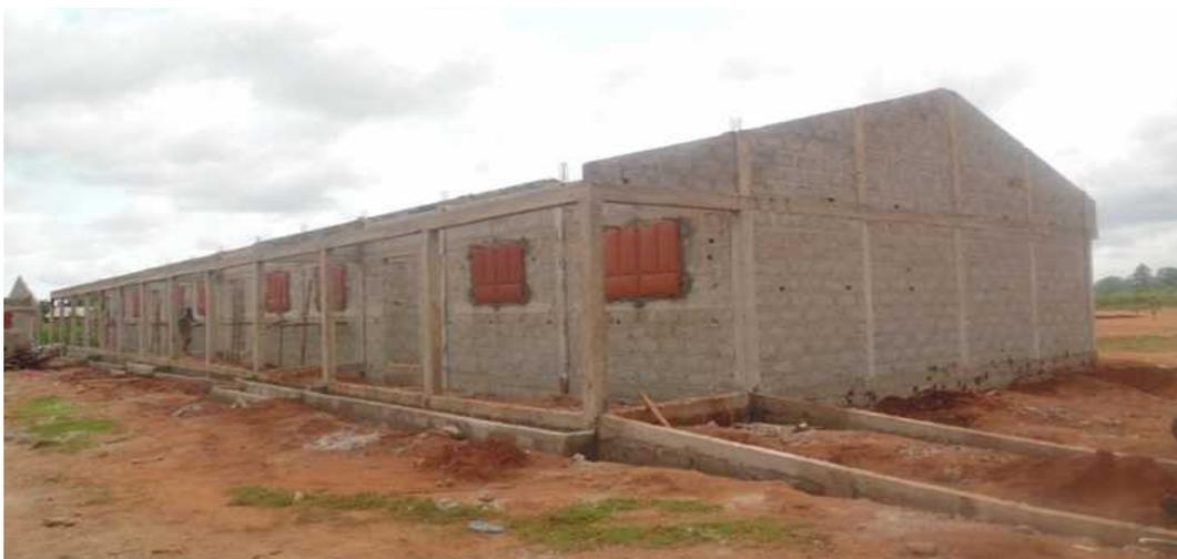
Das Mauerwerk ist fertig und die Fensterläden wurden eingesetzt
