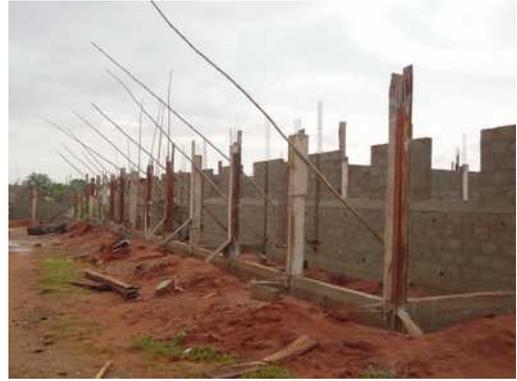
Die Mauern wachsen auf dem unteren Eisenanker. Die Eisenverbindungen zu den Treppen sind eingearbeitet, der kleine Eisenanker unterhalb der Fensteröffnungen gegossen und die Verschalungen für die Pfeiler an der Veranda angebracht.
