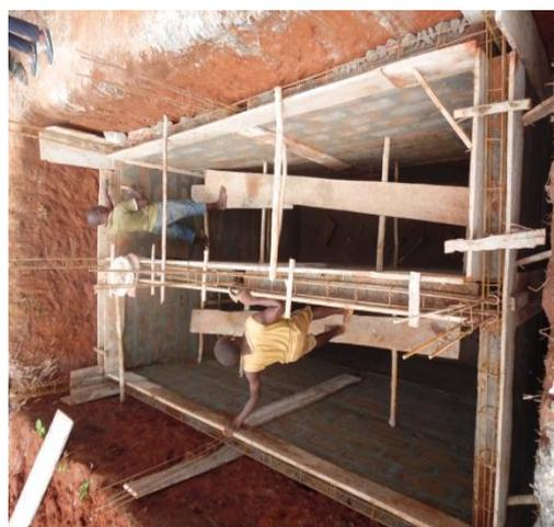
貯留層を壁で補強します。
