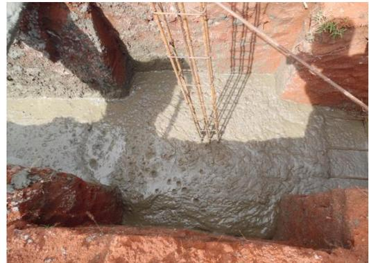
基礎固め用の鉄筋工事
