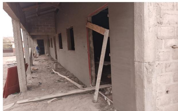
In den Putz für die Außenwände werden Sikalite und Sikalatex untergemischt, damit kein Regenwasser in den Putz eindringen kann.
