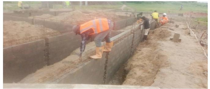
Der untere Eisenanker wird verschalt und gegossen. Darüber werden die Mauern des Gebäudes errichtet.
