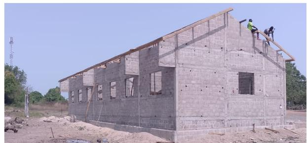
Anschließend werden die Dachdeckplatten angeschraubt.
