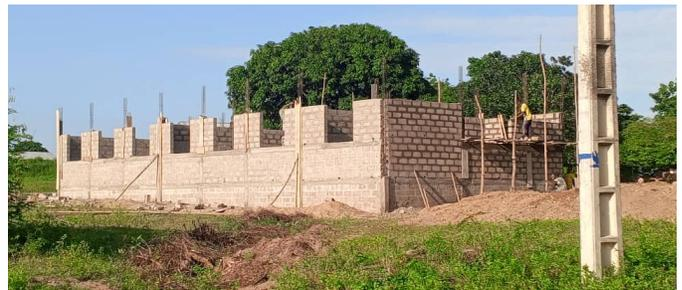
Unterhalb der Fensteröffnungen wird ein kleiner Eisenanker eingezogen. Dann wachsen die Mauern bis zum Fenstersturz. Die Pfeiler der Veranda werden gegossen. Dann wird der Eisenanker darüber in einem Stück gegossen.
