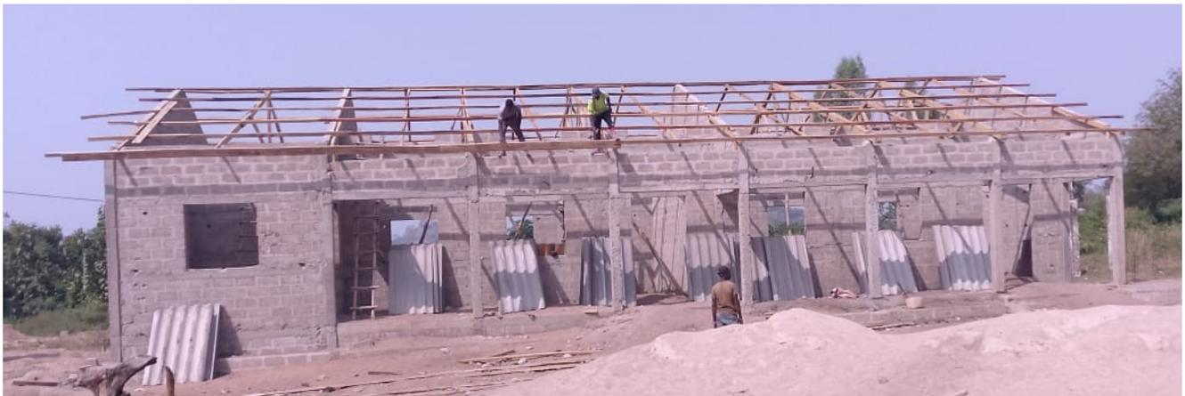
und das Dach wird mit den Eisen am Gebäude befestigt. Die Enden werden versäubert.
