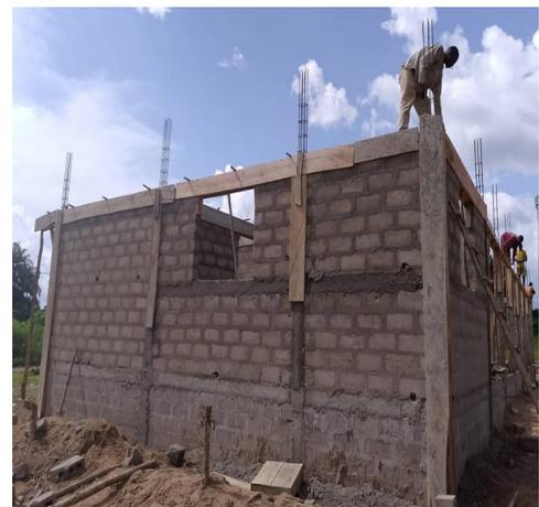
Auf dem oberen Eisenanker werden die Mauern errichtet.
