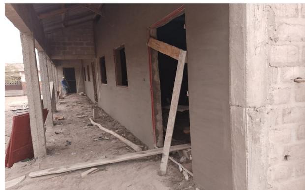
Sikalite et Sikalatex sont mélangés à l'enduit des murs extérieurs pour empêcher l'eau de pluie de pénétrer dans l'enduit.
