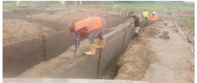
Le chaînage de bas est coffré et coulé. Les murs du bâtiment sont construits au-dessus de cela.
