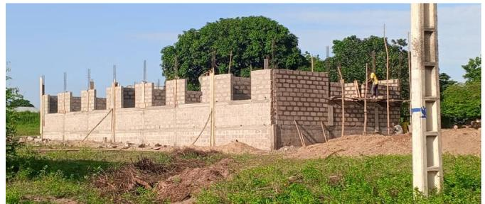
Une petite chaînage est insérée sous les ouvertures des fenêtres. Ensuite, les murs grandissent jusqu'au linteau. Les piliers de la véranda sont en cours d'être coffrer. Ensuite, le chaînage de haut est coulé dessus en une seule pièce.
