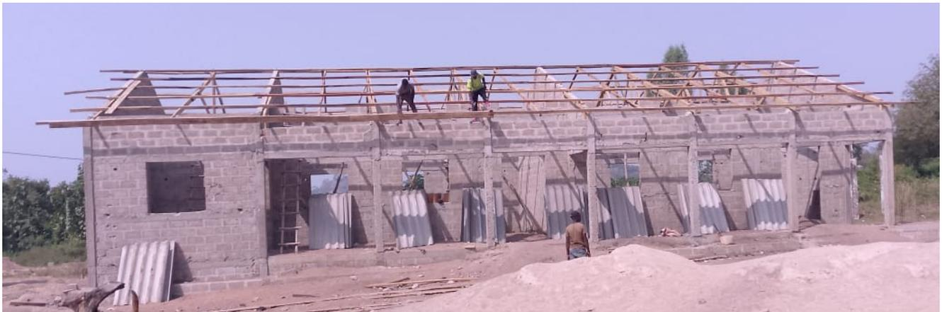
et le toit est attaché au bâtiment avec du fer. Les extrémités sont nettoyées.
