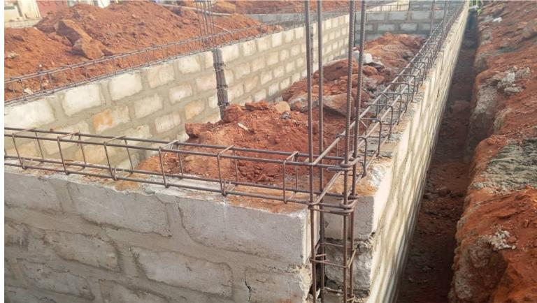
Sur ce chaînage les murs du bâtiment sont construits. Un petit chaînage est inséré lorsque les murs atteignent la hauteur des ouvertures des fenêtres.
