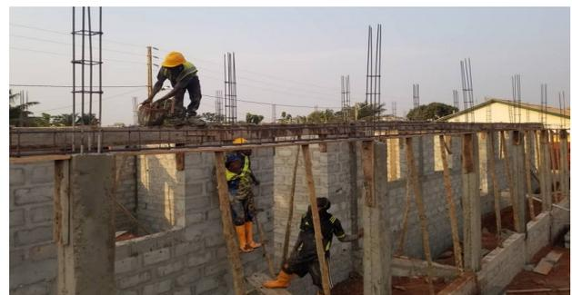
Les murs sont ensuite élevés de 4 rangées de briques avant que le quatrième chaînage sous le toit ne soit coulé.
