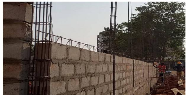
Les murs s'élèvent ensuite rapidement jusqu'au linteau des fenêtres. Une fois les piliers de la véranda coulés, le chaînage de haut est placé, coffré et coulé d'une seule pièce.
