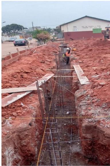
La deuxième couche de béton armé est coulée par-dessus. Une fois sèche, les murs de fondation sont construits par-dessus.
