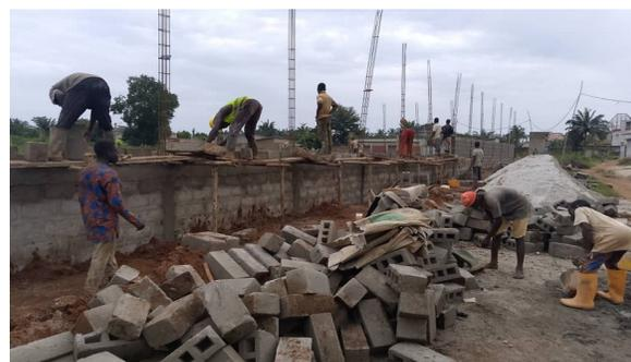
Unterhalb der Fensteröffnungen wird ein kleiner Eisenanker eingezogen. Dann wachsen die Mauern bis zum Fenstersturz.
