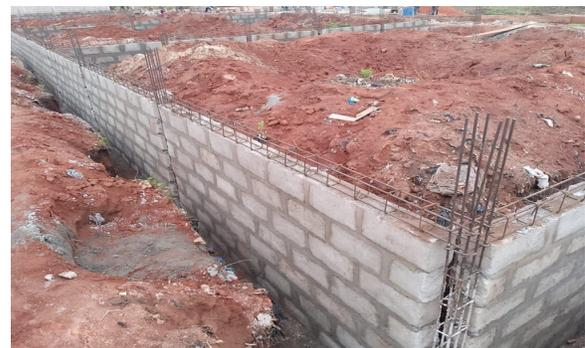
Der untere Eisenanker wird verschalt und gegossen. Darüber werden die Mauern des Gebäudes errichtet.
