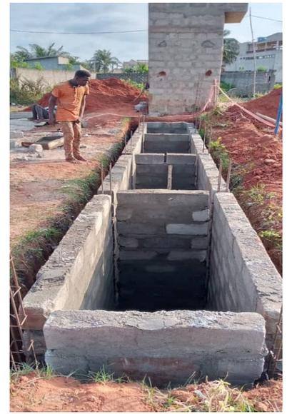
Ehe die Grube verschlossen wird, wird sie mit Sikalite und Sikalutex verputzt.
