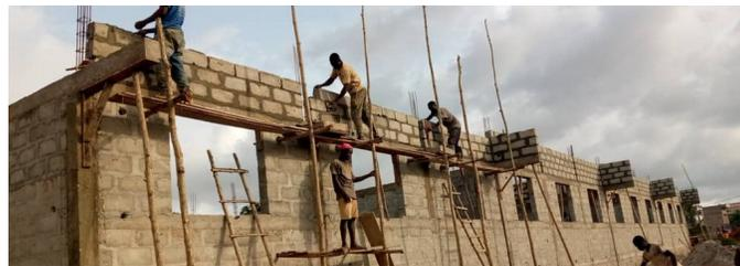
Nach vier Bausteinreihen wird der Eisenanker unterhalb des Daches vorbereitet. Darauf werden die Giebel errichtet.
