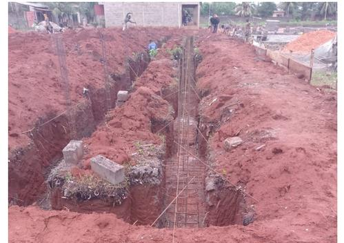
Darauf werden die Fundamentmauern bis zum unteren Eisenanker errichtet.
