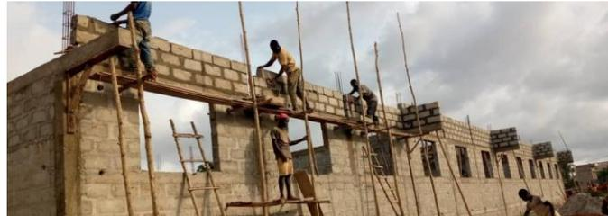
ブロックを 4 列積み上げた後、屋根の下の鉄アンカーを準備します。そして、その上に破風を建てます。
