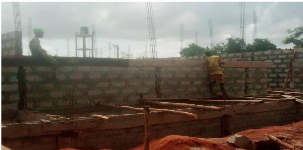
Gebäude 2: Die Errichtung der Grundmauern geht sehr gut voran und die Eisenbieger bringen an einigen Stellen die unteren Eiseneinlagen an. Der Verschaler fertigt die Verschalung, der Anker wird aber noch nicht gegossen. Die Erdkabel von Gebäude 2 werden vom Elektriker Herrn Roméo Loukibou verlegt.
