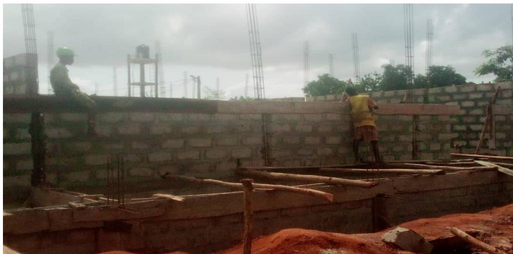
Bâtiment 2 : L'élévation des murs de la fondation se poursuivent très bien, et les ferrailleurs ont monté les fers du chaînage de bas sur quelques endroits. Le coffreur a réalisé les coffrages, mais rien est encore coulé. Le câbles de terre du bâtiment 2 est placé par l'électricien Mr Roméo Loukibou.
