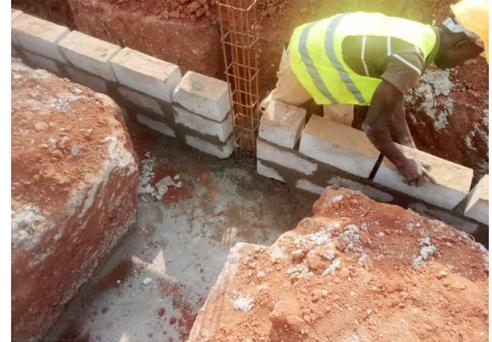
Une fois les inserts en fer intégrés à la fondation, la deuxième couche de béton est coulée dessus. Les murs de fondation sont construits par-dessus.
