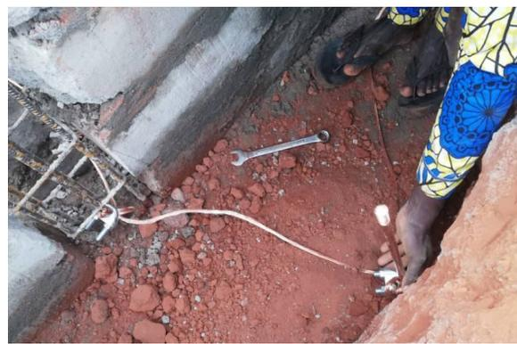
Les électriciens ont mis la terre. L'ancrage inférieur en fer est coulé. Et déjà les murs du bâtiment sont érigés.
