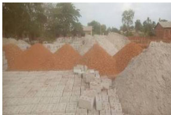
Les maçons commencent immédiatement à fabriquer les blocs de construction et les ferailleurs préparent la base en fer pour les tranchées de fondation.
