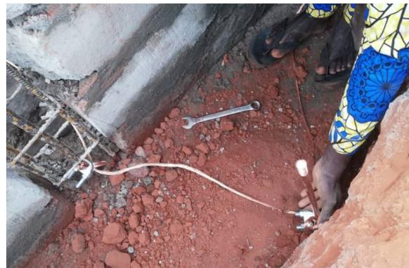
電気工がアースを備え付けました。下の鉄制定着部にセメントが流されます。すると建物の壁が建って行きます。
