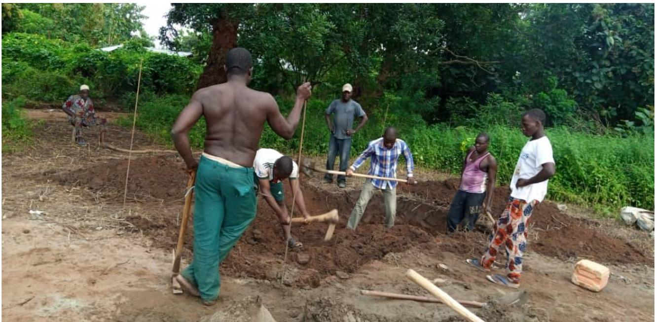
Nous avons eu une montée d'eau à la surface déjà à une profondeur de 1,5 m.
