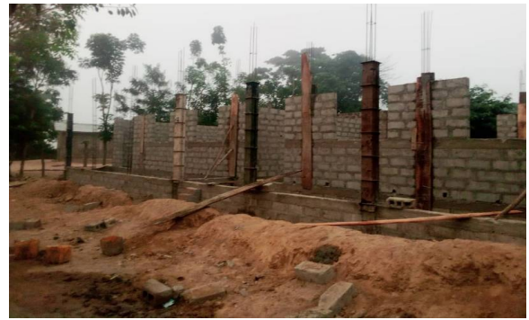
Les piliers sont coulés
