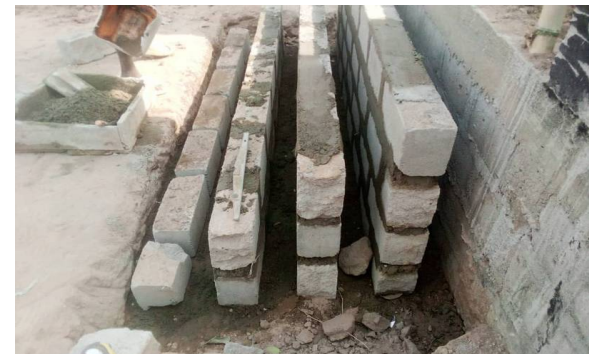
Les escaliers sont aménagés.
