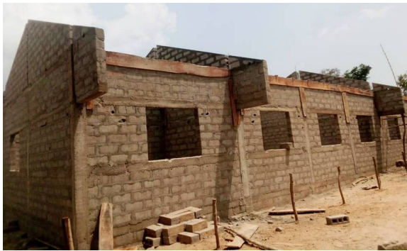
Les pignons sont maçonnés.
