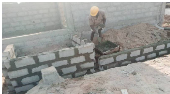
La rampe d'accès est réalisée.
