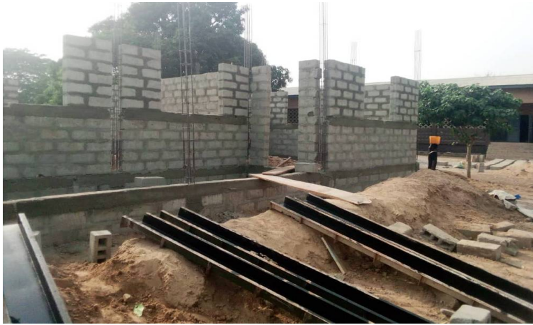
Les murs continuent de pousser et les coffrages métalliques pour les piliers de la véranda sont prêts.
