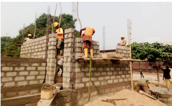
Des échafaudages audacieux !
