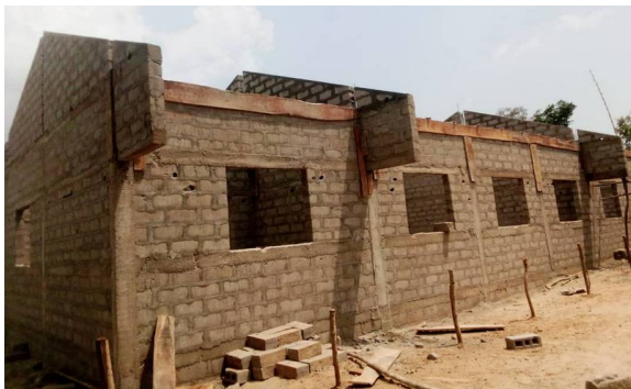
破風壁が出来ました。
