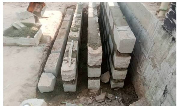
入口の昇り階段も進んでいます。
