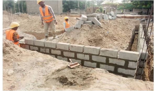
壁の基礎が延びていきます。
