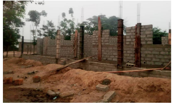
鉄筋柱にセメントが流されます。階段
