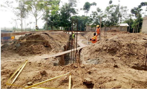
柱の鉄芯ができました。
