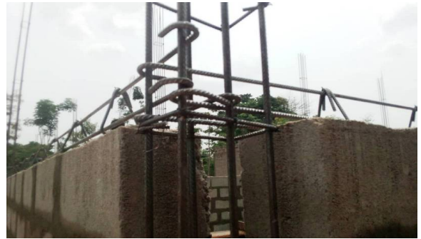
窓の下の鉄筋もきちんと組み合わさっています。
