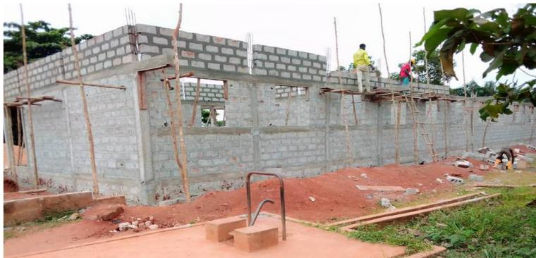
Ein vierter Eisenanker wird unterhalb des Daches gegossen, ehe darauf die Giebel errichtet werden. Zum Schluß werden die Enden der Pfeiler verschalt und gegossen.
