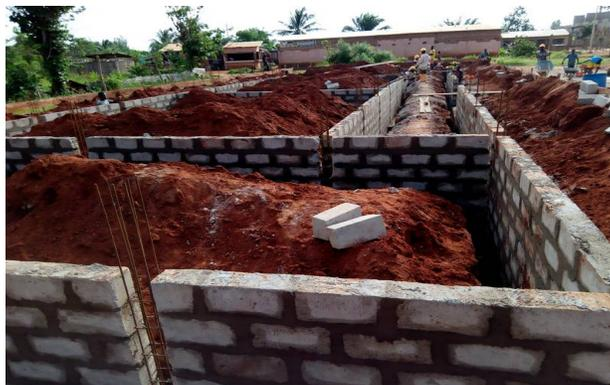
Die Eiseneinlage für den unteren Eisenanker wird verankert. Die Verschalung des unteren Eisenankers wird gemacht. Auf dem unteren Eisenanker wachsen die Mauern des Gebäudes.
