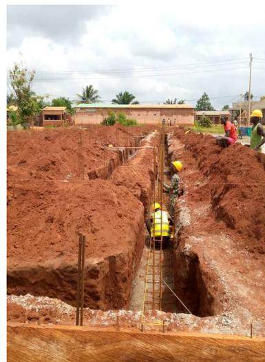
Darüber wird eine zweite bewehrte Betonschicht gegossen und darauf werden die Fundamentmauern errichtet.
