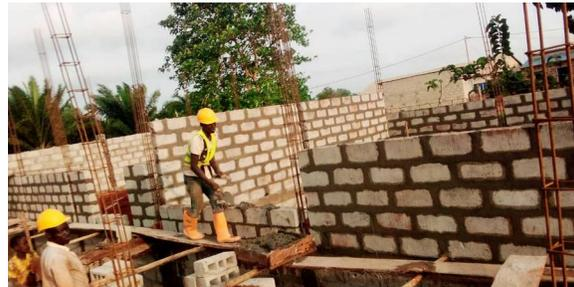
Unterhalb der Fensteröffnungen wird ein kleiner Eisenanker eingearbeitet und darauf die Mauern bis zum Fenstersturz errichtet.
