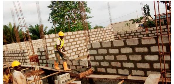
Le chaînage alège est incorporée sous les ouvertures des fenêtres et les murs sont construits jusqu'au linteau.
