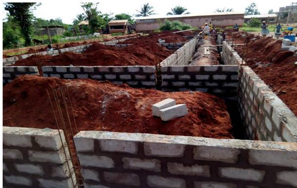
Les fer pour le chaînage de bas est placé. Le coffrage du chaînage est réalisé et le béton coulé. Les murs du bâtiment poussent dessus.
