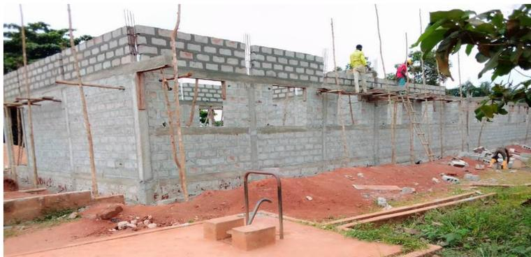
Un quatrième chaînage est coulé sous le toit avant que les pignons ne soient érigés au sommet. Enfin, les extrémités des piliers sont coffrées et coulées.
