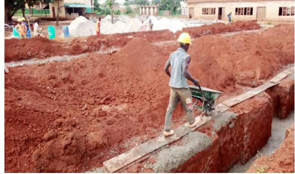
Sur la première couche de béton armé les semelles filantes sont placées et les supports de fer des poteaux y sont incorporées. A l'aide de cordons, ils sont tous alignés et reliés.
