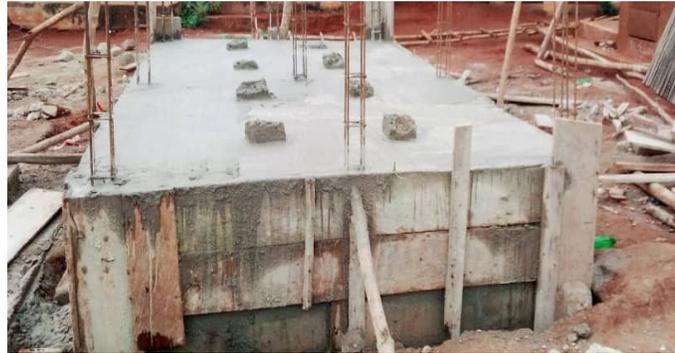
Le bloc sanitaire est construit au dessus de la dalle de fermeture.
