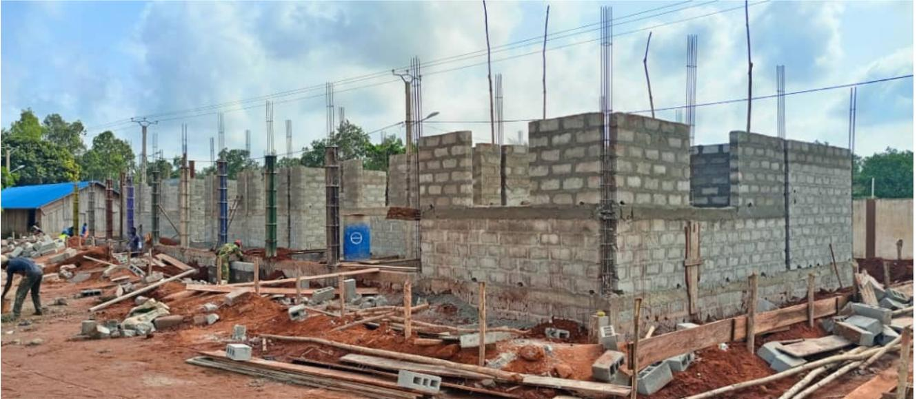
Pendant que le menuisier prépare le coffrage pour le chaînage de haut, les maçons construisent la rampe et les escaliers.
