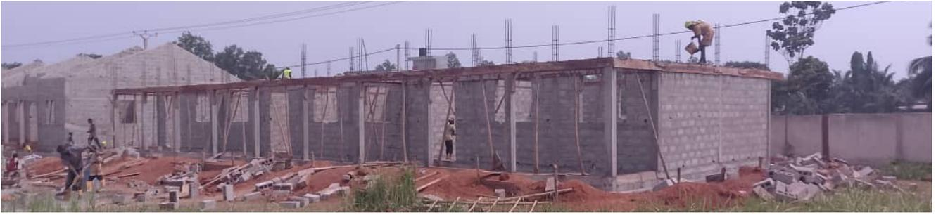
Les murs sont maintenant surélevés de quatre rangées de briques avant que le chaînage sous le toit ne soit réalisé.
