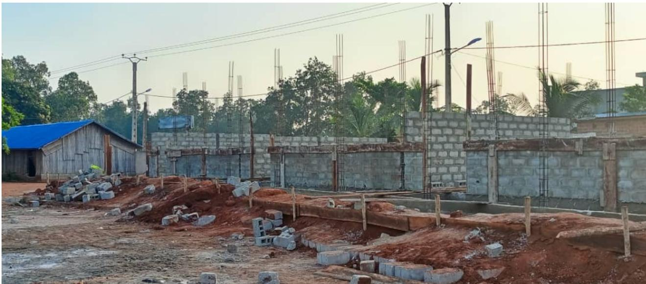
Les murs s'étendent maintenant jusqu'au linteau des fenêtres. Les piliers de la véranda sont en cours de coulage.
