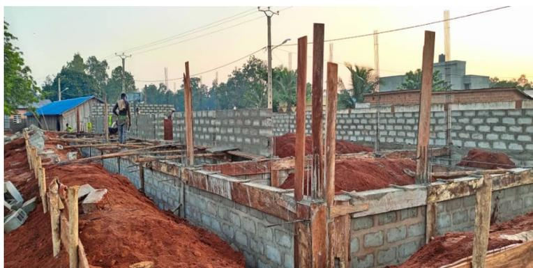
Lorsque les murs atteignent la hauteur des ouvertures des fenêtres, un petit chaînage en fer y est coulé.
