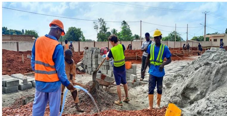
La deuxième couche de béton est coulée sur les armatures en fer. Les murs de fondation sont ensuite construits par-dessus. L'ancrage inférieur est coulé, et les murs du bâtiment sont construits par-dessus.
