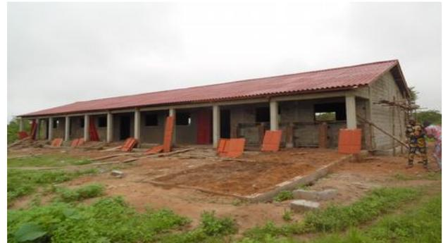
Die Fensterläden und Türen werden eingesetzt. Dann wird das Gebäude verputzt.
