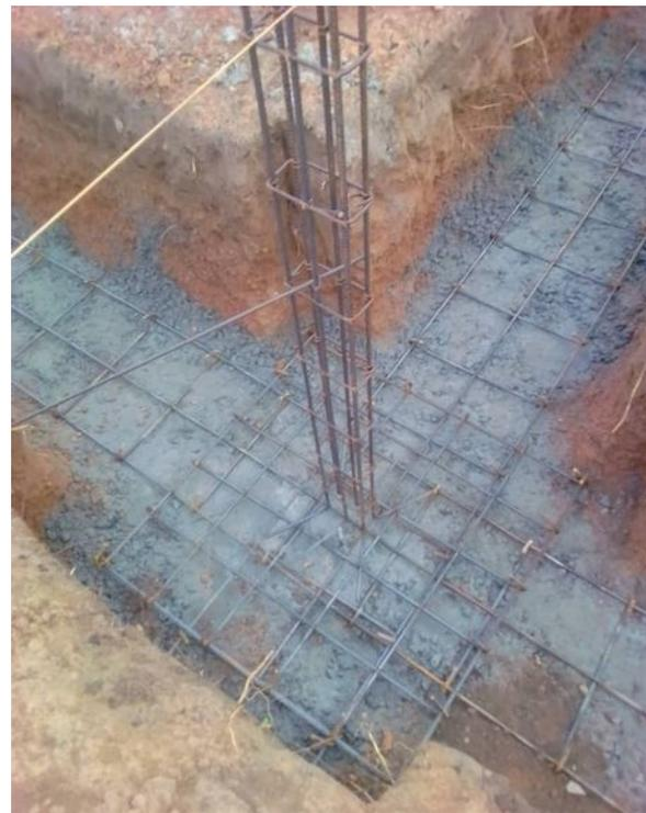
Darüber wird eine weitere bewehrte Betonschicht gegossen. Darauf werden die Fundamentmauern errichtet.
