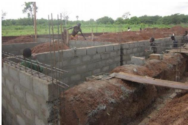
Nachdem der untere Eisenanker gegossen wurde, entstehen die Mauern des Gebäudes..
