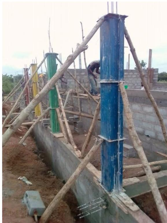
Der obere Eisenanker wird in einem Stück gegossen, Darüber entstehen die Giebel.
