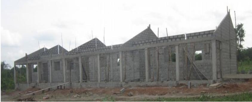
Die Wände trocknen zwei Wochen lang, dann wird der Dachstuhl gemacht und die Dachdeckplatten werden aufgelegt.
