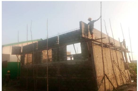
Ein vierter Eisenanker wird unterhalb des Daches gegossen, ehe darauf die Giebel errichtet werden. Zum Schluß werden die Enden der Pfeiler verschalt und gegossen.
