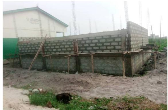
An der Veranda werden die Pfeiler verschalt und gegossen.
