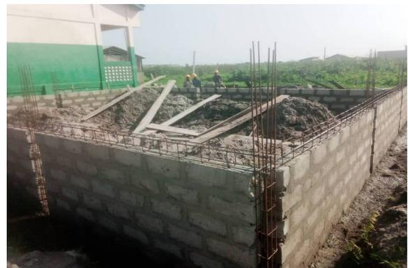
Der untere Eisenanker wird aufgelegt, verschalt und gegossen. Und schon wachsen die Mauern des Gebäudes bis zu den Fensteröffnungen heran.
