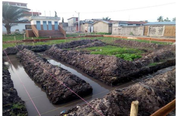
Selbst die Fundamentunterlage muß verschalt werden, damit sie nicht mit dem Wasser davon schwimmt.
