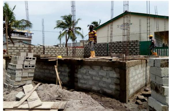
Der kleine Eisenanker wird aufgelegt und gegossen.
