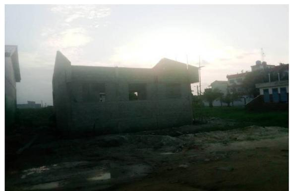
Pendant que les murs se séchaient, l'escalier est posé et le bâtiment est remblayé de sable.
