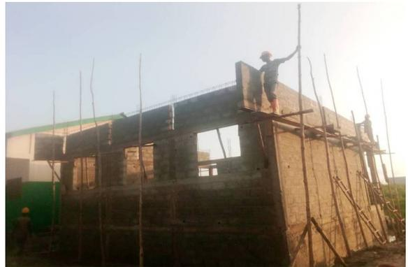
Un quatrième chaînage est coulé sous le toit avant que les pignons ne soient érigés sur là-dessus. Enfin, les extrémités des piliers sont coffrées et coulées.
