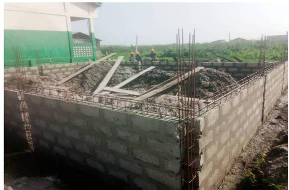
Le chaînage de bas est posé, coffré et coulé. Et déjà les murs du bâtiment poussent jusqu'aux ouvertures des fenêtres.
