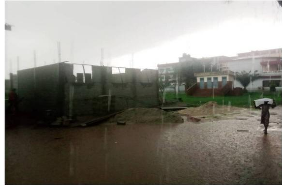
Le chaînage de haut est coulé en une seule pièce. Les murs sont ensuite augmentés de quatre rangées de blocs de construction.
