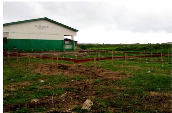
Les travaux d'excavation des tranchées de la fondation ont été très difficiles car la terre excavées retourne rapidement dans les tranchées. L'eau doit être pompée plusieurs fois par jour.
