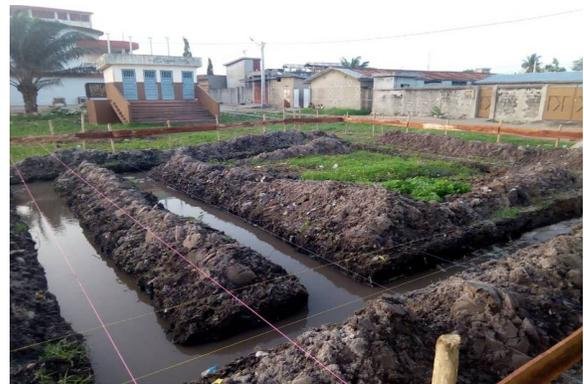
Même la base de la fondation doit être coffrée pour que le béton ne flotte pas avec l'eau.
