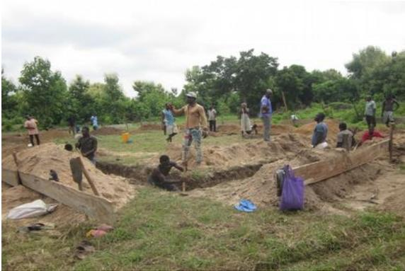
Beim Ausheben der Fundamentgräben stossen wir auf Felsen. Wir entschliessen uns, sie in das Fundament zu integrieren.
