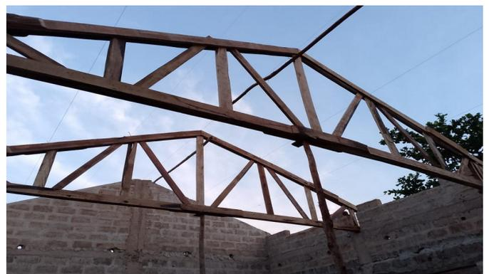
Die Querbinder werden mit den Eisenstangen der Pfeiler festgezurr. Die Längsplanken werden befestigt.
