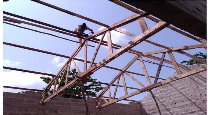
Der ganze Dachstuhl wird schließlich mit glatten Eisenstangen am Gebäude fest gemacht.
