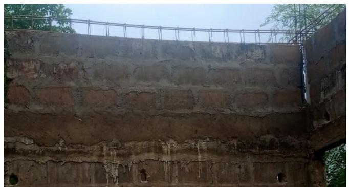
Nachdem der Eisenanker gegossen wurde, werden die Giebel aufgemauert.
