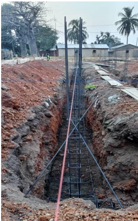
基礎溝が掘られると、石工たちは最初のコンクリートの層を流し込み、鉄筋を設置して、柱を立てます。型枠のおかげで、この作業は比較的容易です。そして2層目のコンクリートを流し込みます。
