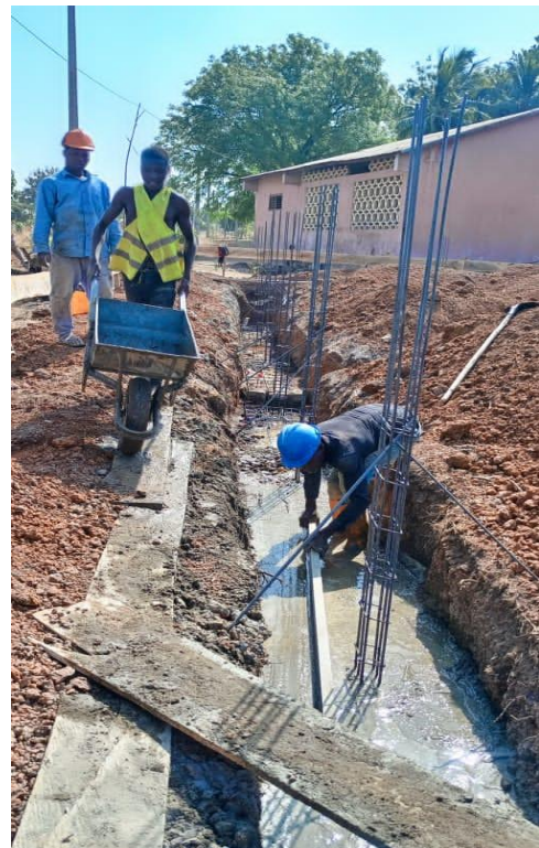
基礎溝が掘られると、石工たちは最初のコンクリートの層を流し込み、鉄筋を設置して、柱を立てます。型枠のおかげで、この作業は比較的容易です。そして2層目のコンクリートを流し込みます。
