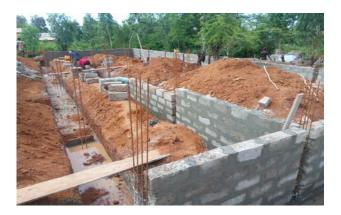
Auf dem unteren Eisenanker wuchsen die Wände. Darüber wurde der kleine Eisenanker unterhalb der Fensteröffnungen gegossen.
