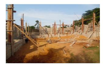
Bald war das Mauerwerk der Gebäude fertig. Wir liessen es zwei Wochen gut trocknen. In der Zwischenzeit haben wir die Bohlen für den Dachstuhl gekauft und im Sägewerk zuschneiden lassen.
