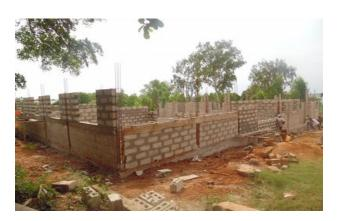
Als die Mauern die Höhe des Fenstersturzes erreicht hatten, wurde die Verschalung des oberen Eisenankers vorbereitet. Im Innenbereich wurden die Pfeiler an der Veranda verschalt und anschliessend gegossen.
