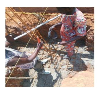
Darüber wurde eine weitere bewehrte Betonschicht gegossen. Danach begannen die Mauern mit grosser Geschwindigkeit über den Fundamentgräben hinaus zu wachsen.
