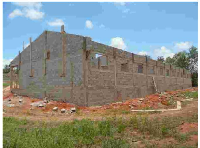
上部の鉄筋アンカーが完成し、破風が造られます。
