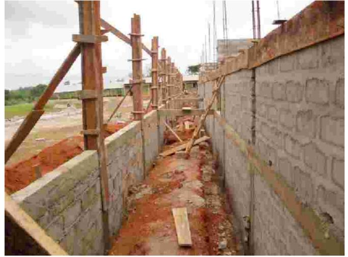
ベランダの柱と窓枠下辺の鉄筋に型枠が設置され、コンクリートが打たれます。
