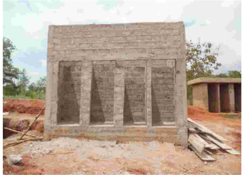
セメントブロックの壁で補強したトイレの貯留槽を閉じた上に、
