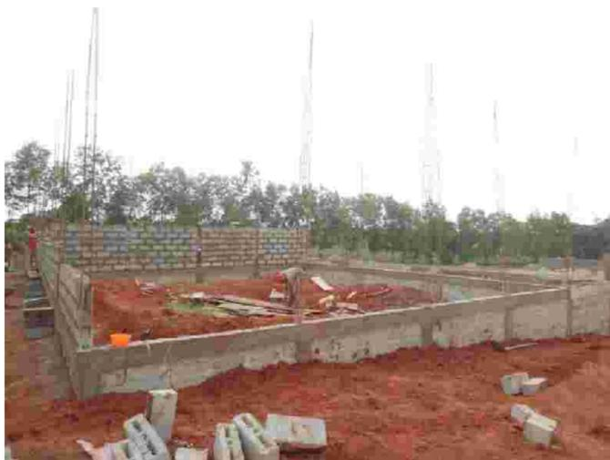
基礎壁と下部の鉄筋アンカーが
