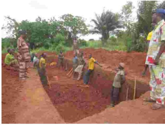
トイレの貯留槽の掘削作業も順調です。
