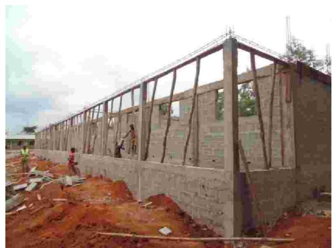
両方の建物にて、上部の鉄筋アンカーにコンクリートを打つための型枠が設置されます。これは全てが一体に仕上がるよう、一度にコンクリートを流す必要があります。
