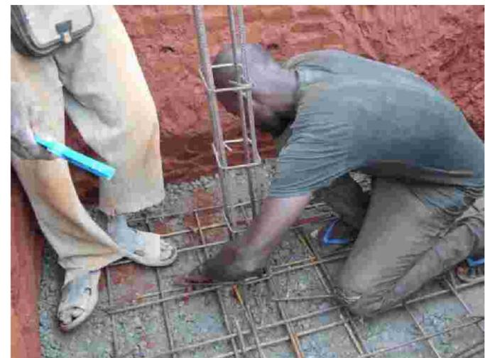
壁と柱の鉄筋が固定されます。
