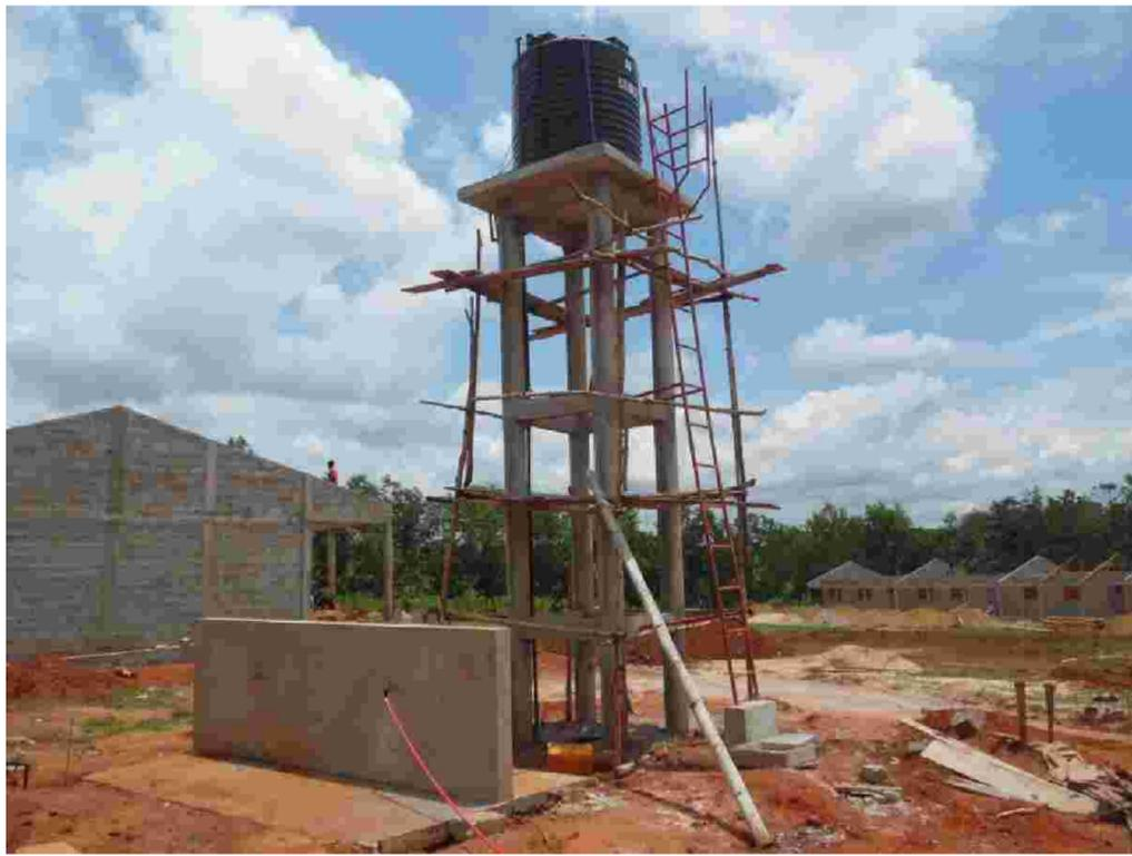
給水塔も完成し、ポンプが取り付けられ、タンクが載せられ、塔に上る梯子が設置されました。
