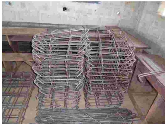
基礎壁と支柱に入れる鉄材が加工されます。
