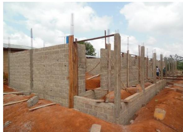
Die Fundamentmauern haben schnell die Grasnarbe erreicht. Und weiter geht es! Die Mauern wachsen auf dem unteren Eisenanker, die Pfeiler der Veranda sind gegossen.
