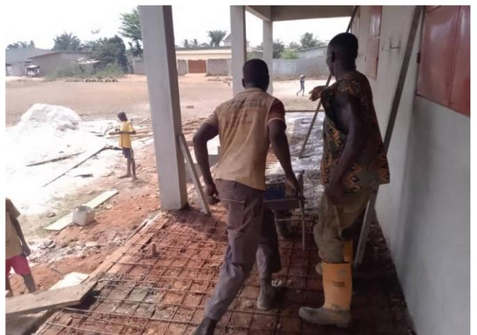
ベランダ、階段、スロープがきれいに打設されていきます。
