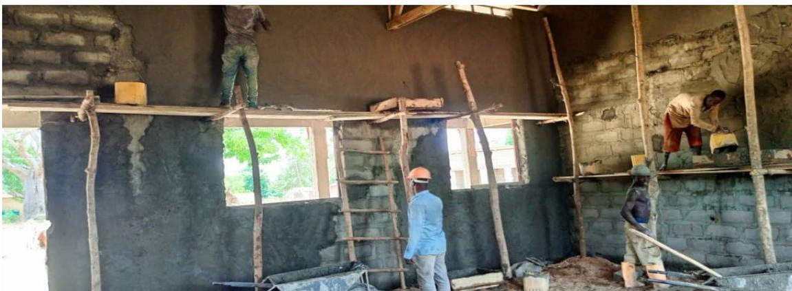
D'abord l'intérieur des salles de classe est crépis et les tableaux sont créés, suivis des murs extérieurs.
