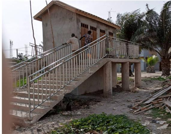
Darüber werden die Toilettenkabinen errichtet. Da die Schule nicht weit vom Meer entfernt liegt, haben wir ein Dach aus Eternitplatten aufgesetzt. Wellblech würde bei der salzigen Luft zu schnell rosten. Die Geländer wurden angebracht.
