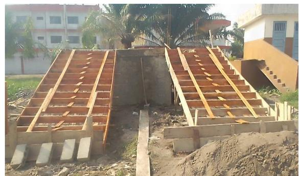
Eine große Deckplatte wird gegossen, damit die Treppenaufgänge Platz haben.
