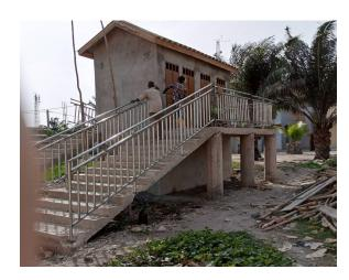
Les cabines de toilettes sont construites au-dessus. Comme l'école n'est pas loin de la mer, nous avons mis un toit en tuiles. La tôle ondulée rouillerait très vite à cause de l'air salin. Les garde-corps ont été posés.
