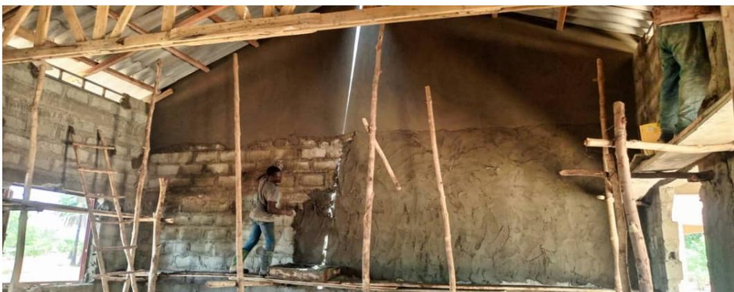
Danach werden die Außenwände mit Sikalit und Sikalutex verputzt, damit kein Regenwasser in den Putz eindringen kann.
