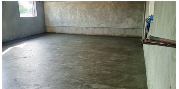
Der Boden der Veranda wird mit Eisen verstärkt und zementiert.
