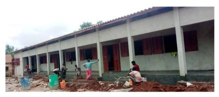
Ensuite, les sols sont cimentés, les escaliers et la rampe réalisés. Le sommet du toit est également fermé.
