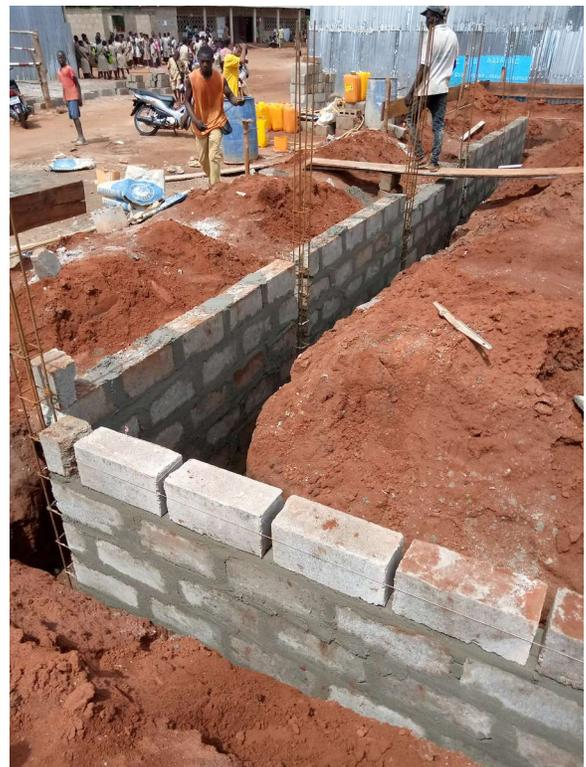
Auf der bewehrten Fundamentunterlage werden die Mauern errichtet. Schnell haben die Fundamentmauern die Höhe des unteren Eisenankers erreicht. Vor den Augen der Schüler wachsen die Gebäude aus dem Boden.
