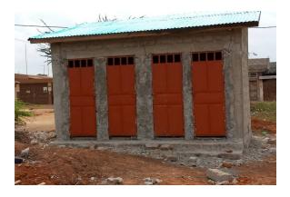
Dès que la toiture a été réalisée, les travaux de crépissage ont commencé à l'intérieur comme à l'extérieur.
