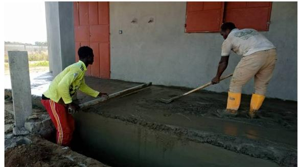
Als das Wasser aus den Toilettengruben entfernt war, konnten die Maurer den Boden ebnen und die bewehrte Betonplatte gießen und darauf die Mauern errichten.
