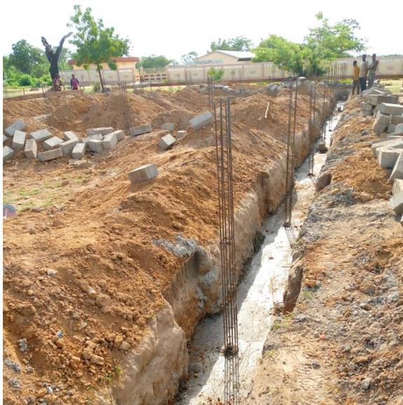
Auf der zweiten Betonschicht wurden die Fundamentmauern errichtet. Die Elektriker legten die Erdung.
