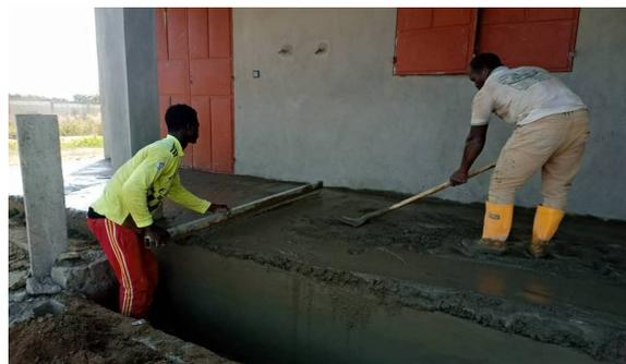
トイレ穴の水が除去されると、左官工が床を平にし、セメント板を流し、その上に壁を造ります。
