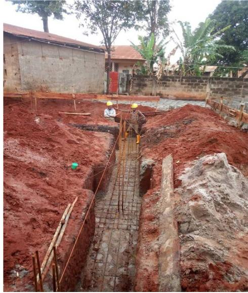
Mit Hilfe von Schnüren und Wasserwaage werden die Pfeiler ausgerichtet.
