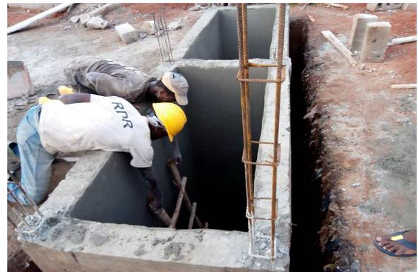
Die Mauern in der Grube werden mit Sikalite verputzt
