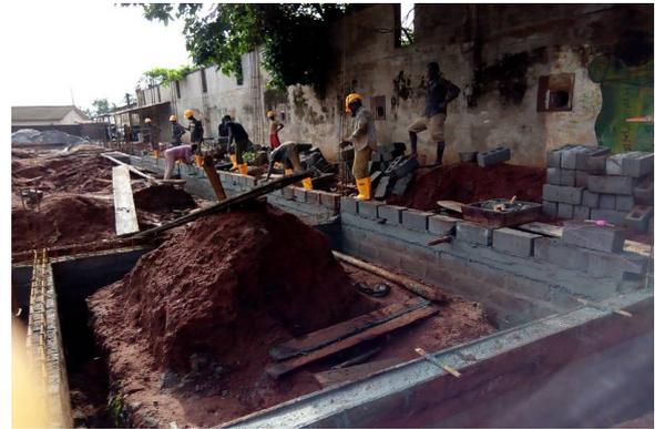
Auf dem unteren Eisenanker werden Bausteine aufgemauert.
