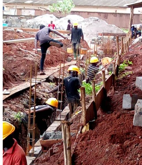
Auf der Fundamentunterlage werden die Mauern errichtet.
