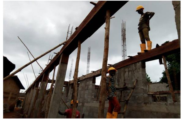
Der obere Eisenanker wird in einem Stück gegossen.
