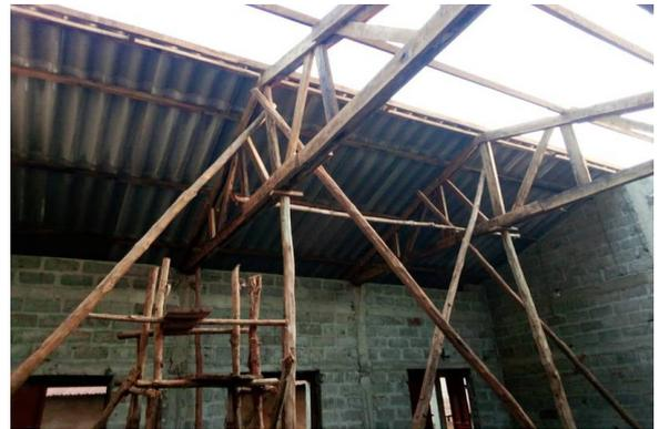
Der Dachstuhl wird gemacht und die Dachdeckplatten aufgelegt.
