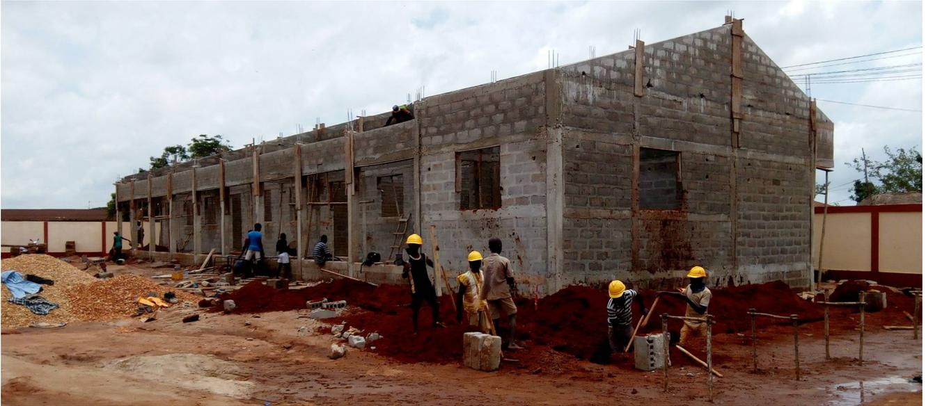
Während die Mauern trocknen, wird die Rampe angelegt und die Leute aus dem Dorf heben die Toilettengrube aus.
