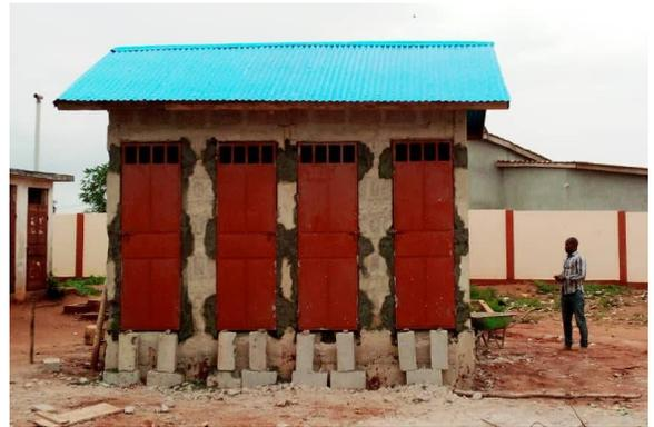
Nachdem die Mauern des Gebäudes gut getrocknet sind, fertigen die Zimmerer den Dachstuhl und legen die asbestfreien Eternitplatten auf.
