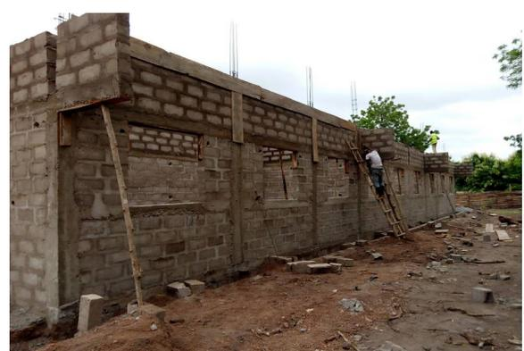
Der Eisenanker unterhalb des Daches wird verschalt
