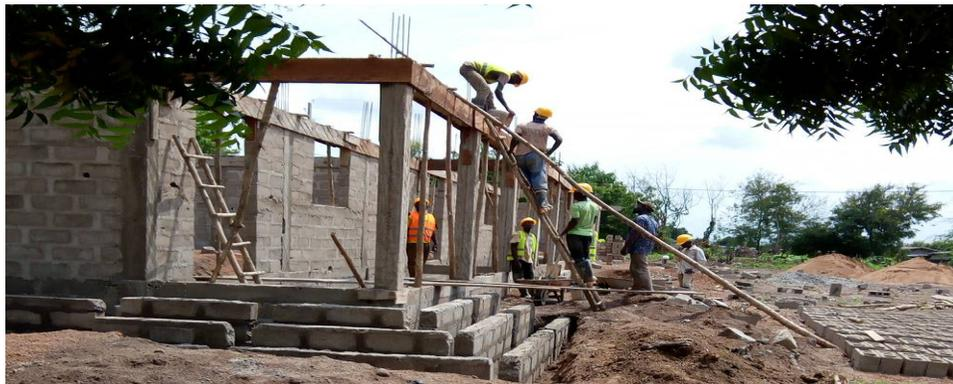
Der Eisenanker über dem Fenstersturz wurde in einem Stück gegossen.
