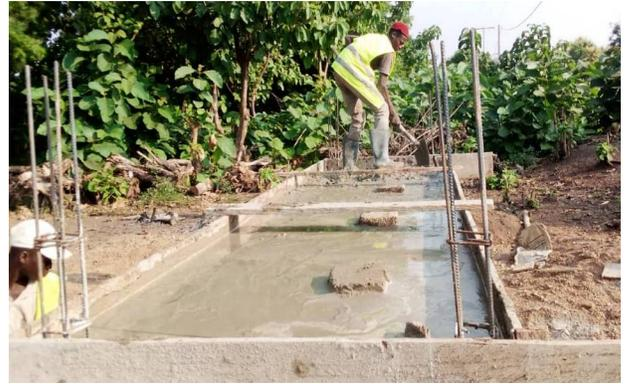
Im Inneren wurde die Grube wasserdicht verputzt und danach mit einer bewehrten Betonplatte verschlossen.
