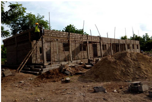
Le chaînage au-dessus du linteau a été coulée en une seule pièce.
