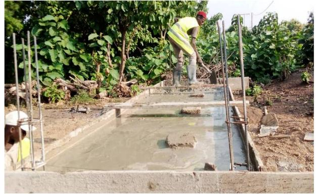
内部の穴は水漏れしないように漆喰を塗り、その後鉄筋コンクリート板で閉ざします。
