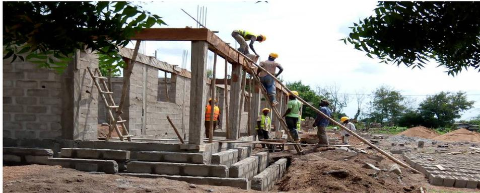
窓枠の上にコンクリートが一度に流されます。
