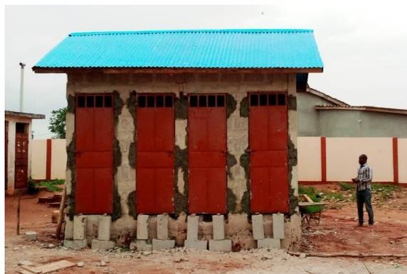
建物の壁が十分乾燥してから、大工が屋根部分を完成させ、アスベスト無しのエタニット板で葺きました。
