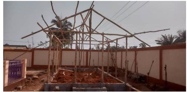
Wir beginnen auch kurz darauf mit dem Bau des Trockenhauses. Ein Fundament aus 4 Bausteinreihen wird gemacht, in das die Holzpfiler einbetoniert werden. Darüber wird das Dach gemacht. Die Frauen füllen das Fundament mit Sand auf. Die Wände werden mit Stammverschnitt geschlossen.
