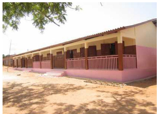
Un bâtiment de 3 salles pour l'école primaire publique de Dekanme.
