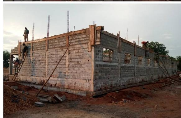
Nach dem oberen Eisenanker wurde ein weiterer Ringanker unterhalb des Giebels gegossen, damit das Gebäude etwas an Höhe gewinnt. Dann wurden die Giebel errichtet und die Fensterläden eingesetzt.
