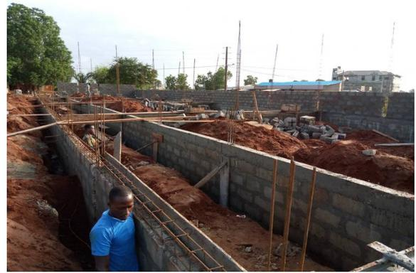
Der untere Eisenanker wurde gegossen und darauf die Mauern des Gebäudes errichtet. Schnell wuchsen die Mauern bis an die Fensteröffnungen heran. Gleichzeitig wurden die Pfeiler an der Veranda gegossen. Um weniger Holz zu benutzen, haben wir Formen aus Metal anfertigen lassen.
