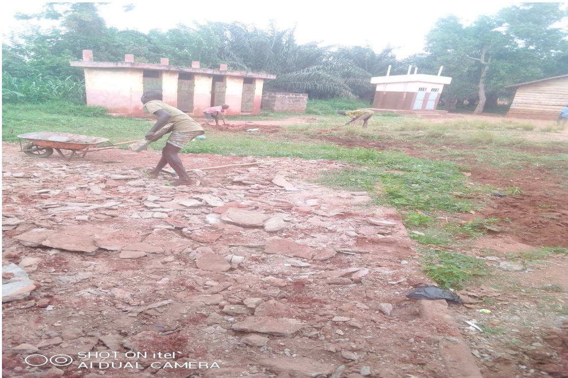
Photos implantation du site
