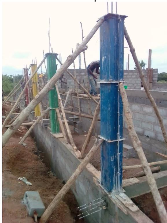
Le chaînage de haut est coulé en une seule pièce puis les pignons sont montés au-dessus.
