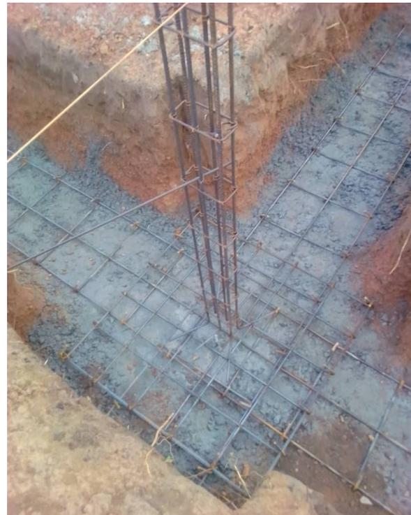
Une autre couche de béton armé est coulée dessus. Les murs de fondation sont construits sur ce point.
