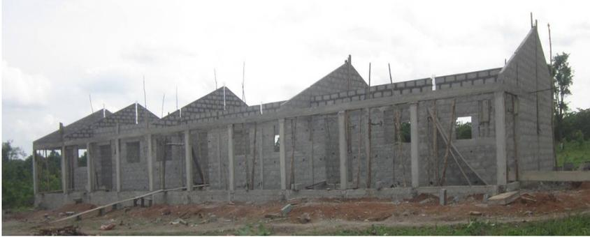
Les murs sèchent pendant deux semaines, puis la charpente du toit est faite et les tuiles sont posées.
