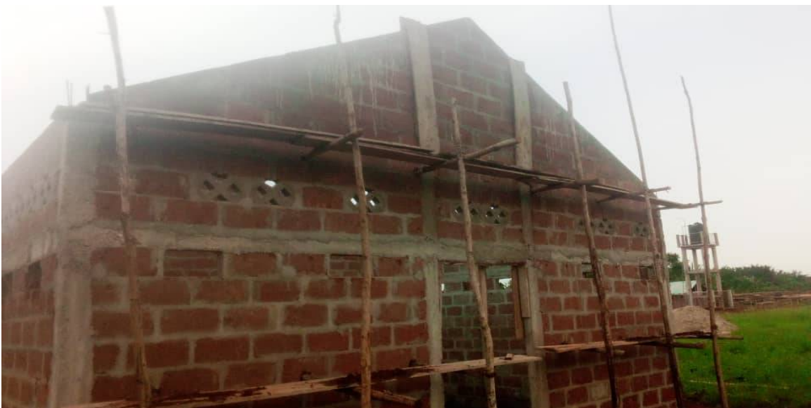
Die Giebel werden errichtet
