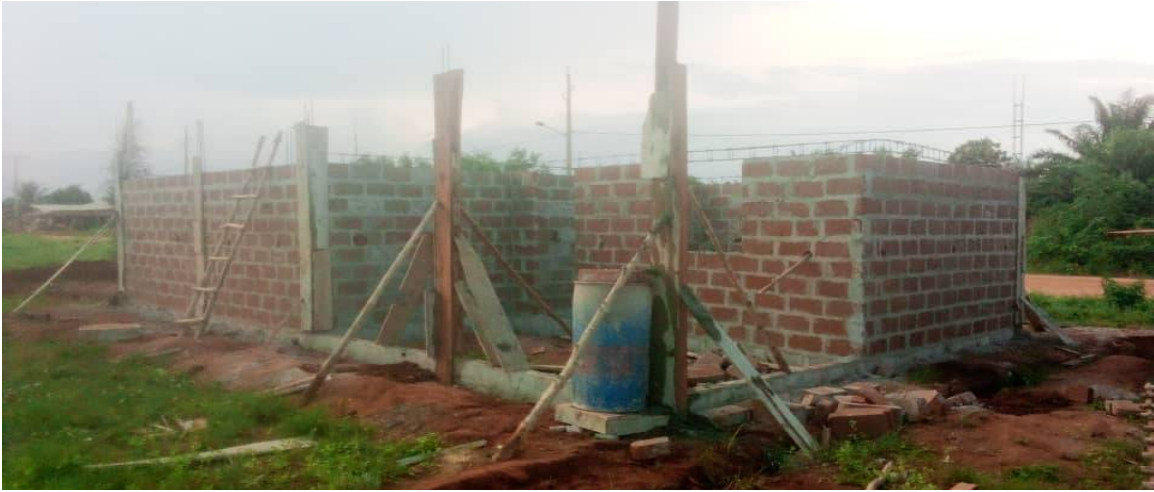
Der obere Eisenanker wird gegossen
