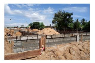
Wegen der Hanglage mußten wir einen zweiten zusätzlichen Eisenanker im Fundament einarbeiten, ehe der normale untere Eisenanker, der die Oberkante des Fundamentes bestimmt, gegossen werden konnte. Auf diesem Eisenanker wurde die Mauern des Gebäudes selbst errichtet.
