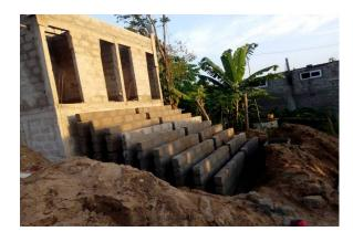
Auch für die Treppenaufgänge mußte ein Fundament gemacht werden, damit sie dem Sand standhalten.
