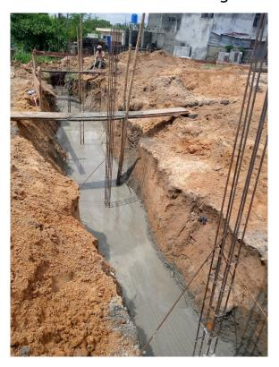
Außerdem haben wir unten im Fundament einen besonders starken Eisenanker mit 14er Eisen eingearbeitet.
