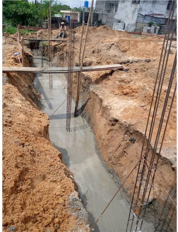
De plus, nous avons incorporé un ancrage en fer particulièrement solide avec du fer de 14 mm dans la base.
