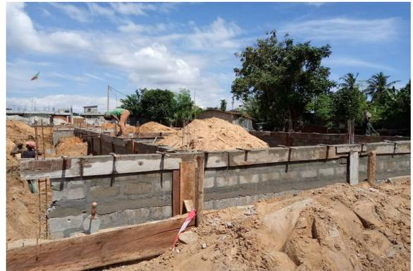
A cause de la pente, nous avons dû incorporer un deuxième chaînage supplémentaire dans la fondation avant que le chaînage de bas normal, qui détermine le bord supérieur de la fondation, puisse être coulé. Les murs du bâtiment même ont été construits sur ce chaînage.
