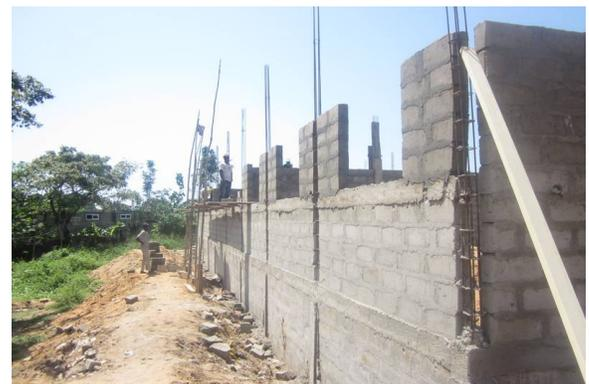
La fondation de la veranda étaient faite à ce moment-là. Le chaînage à liège a été coulé sous les ouvertures des fenêtres.
